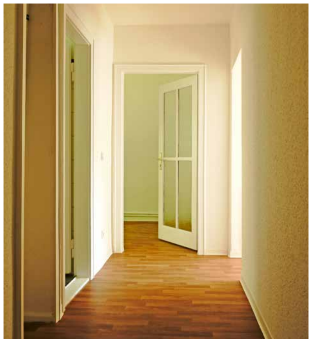
Sanierter Fußboden in PVC-Holzoptik nach der Sanierung
